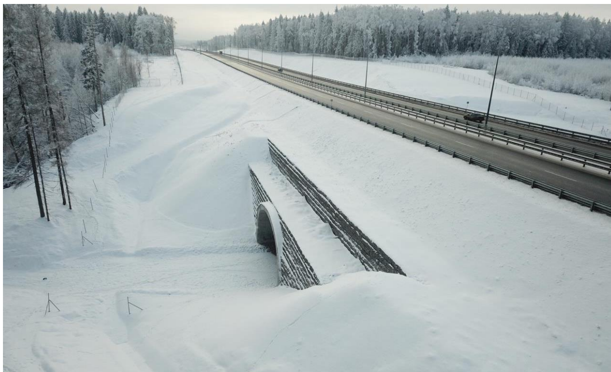
Рис. 1 - Общий вид экодуга на км 84 автомобильной дороги М-11 «Москва – Санкт-Петербург»
