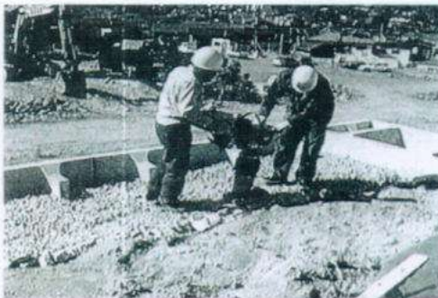
Рисунок 17 - Утрамбовка щебня между подпорной стеной и укрепляемым откосом.
