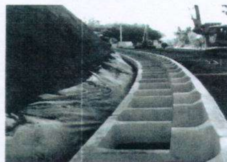
Рисунок 14 - Установка по кривой.
