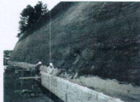
Рисунок 12 - Установка нижнего ряда
