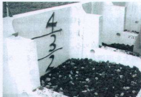
Рисунок 16 - Выровненный слой щебня внутреннего заполнения.
