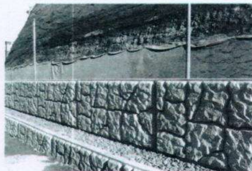
Рисунок 18 - Установка второго ряда.
