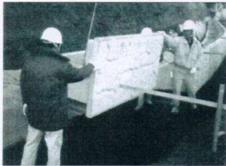
Рисунок 11 - Установка нижнего ряда
