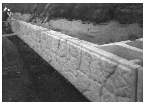
Рисунок 13 - Работы по заделке краев нижнего ряда.
