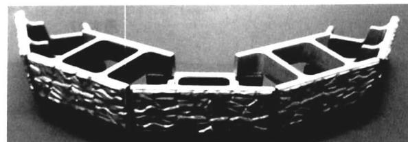
Рисунок 29 (с) - Пример выполнения выпуклой кривой ( $R=5$  м)
