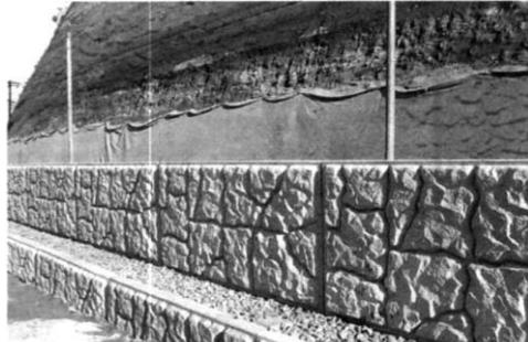
Рисунок 18 - Установка второго ряда.
