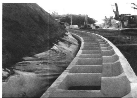
Рисунок 14 - Установка по кривой.
