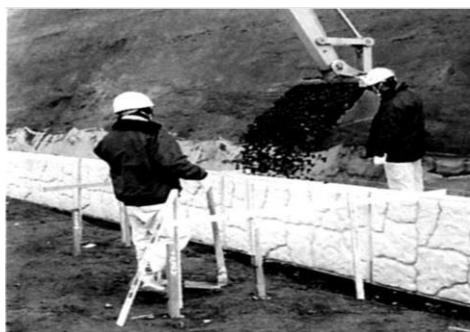
Рисунок 15 - Засыпка заполнителя
