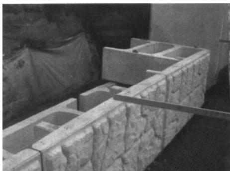
Рисунок 21 - Вид заделанного торца ряда блоков.
