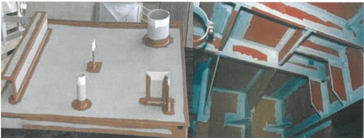
Рисунок 13 - Элементы конструкции после проведения полосовой окраски
