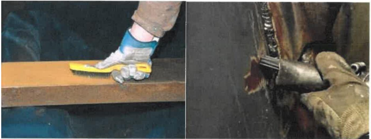
Рисунок 11 - Применение механического инструмента в ходе подготовке поверхности
