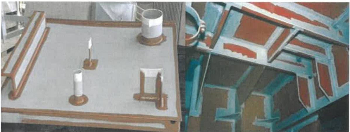
Рисунок 13 - Элементы конструкции после проведения полосовой окраски
