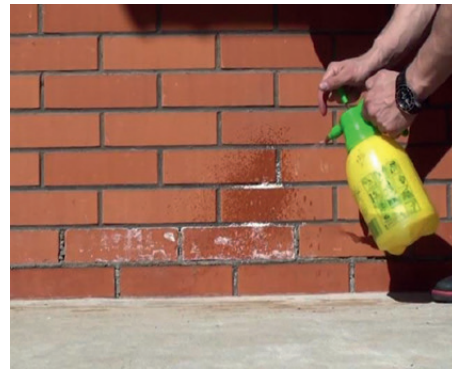
Рисунок 6.27 — Удаление солевых отложений преобразователем солей
