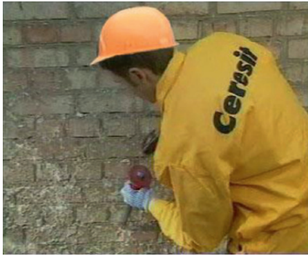
Рисунок 6.24 — Очистка поверхности зубилом и молотком
