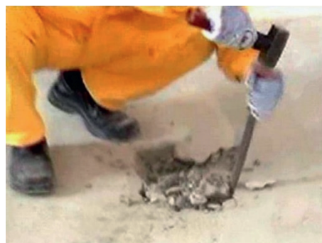
Рисунок 6.30 — Удаление непрочного слоя основания
