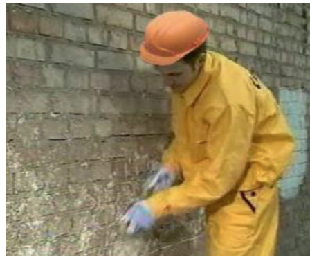
Рисунок 6.25 — Удаление отделочного слоя щеткой
