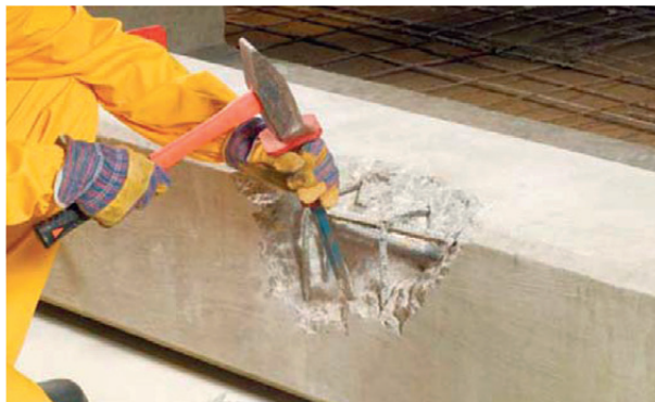
Рисунок 6.1 — Удаление слоев бетона, утративших сцепление с основанием
