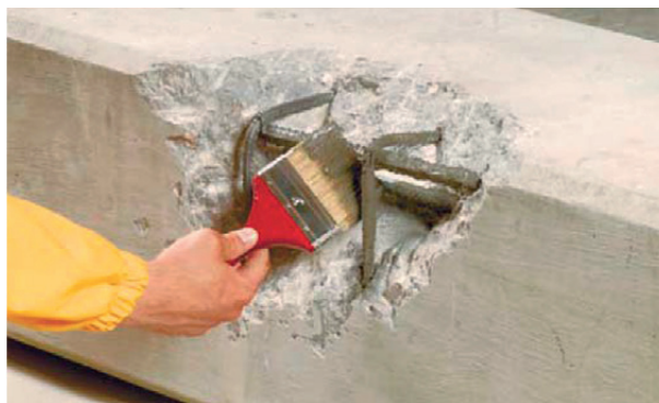
Рисунок 6.4 — Нанесение антикоррозионного слоя ЦЕРЕЗИТ CD 30 на арматуру
