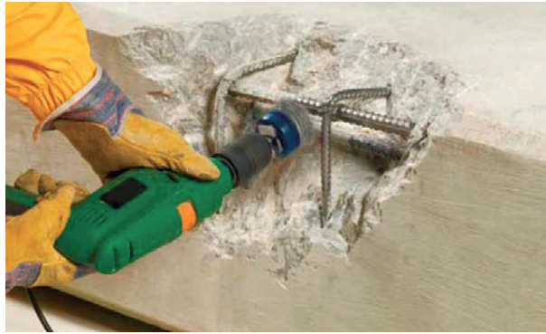
Рисунок 6.2 — Очистка от ржавчины арматурных стержней при помощи стальной щетки
