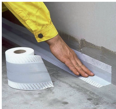
а) – Укладка ленты
