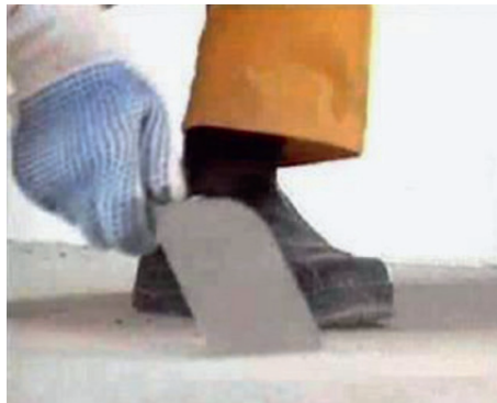
Рисунок 6.28 — Удаление цементного молочка шпателем
