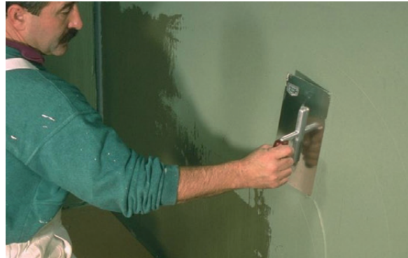
Рисунок 6.37 — Нанесение второго слоя гидроизоляционной смеси ЦЕРЕЗИТ CR 65 при помощи штукатурной кельмы
