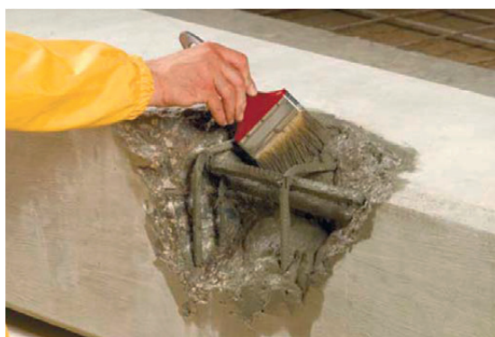
Рисунок 6.5 — Нанесение адгезионного слоя ЦЕРЕЗИТ CD 30 на бетон
