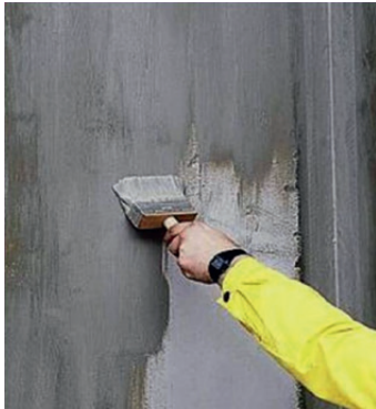
Рисунок 6.36 — Нанесение первого слоя гидроизоляционной смеси ЦЕРЕЗИТ CR 65 или ЦЕРЕЗИТ CR 166
