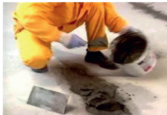
Рисунок 6.32 — Заделка выбоин и впадин составом ЦЕРЕЗИТ СN 83
