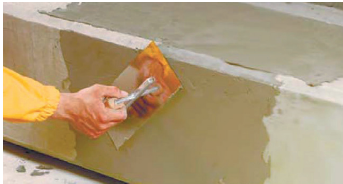
Рисунок 6.6 — Заглаживание ремонтной смеси ЦЕРЕЗИТ CD 25 стальной гладилкой
