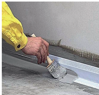
б) – Нанесение второго слоя гидроизоляционной смеси
