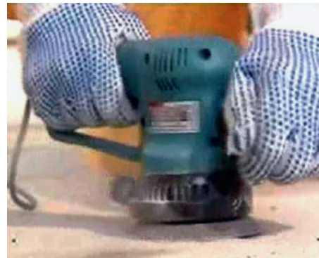
Рисунок 6.29 — Удаление пятен от битума, красок шлифовальной машиной
