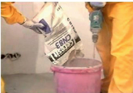
Рисунок 6.31 — Приготовление состава ЦЕРЕЗИТ СN 83
