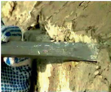
Рисунок 6.26 — Удаление штукатурного слоя
