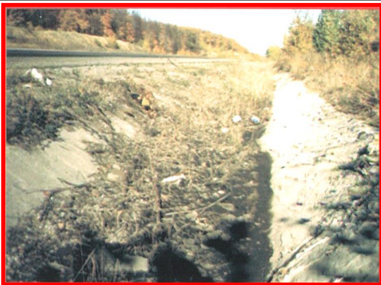
Не очищенная от мусора система водоотвода (водоотводные, прикромочные лотки, быстротоки, нагорные канавы и т.д.)
