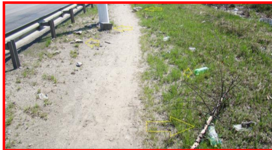
Наличие мелкого мусора на откосах
