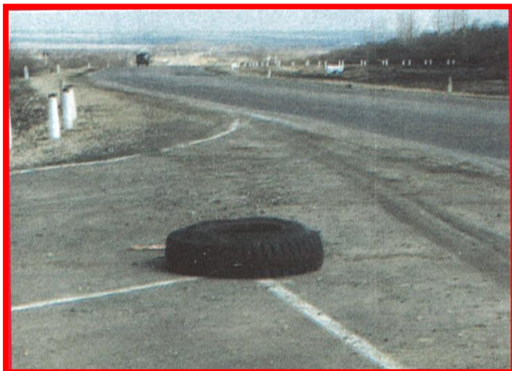
Наличие посторонних предметов на обочинах и разделительной полосе влияющих на безопасность
