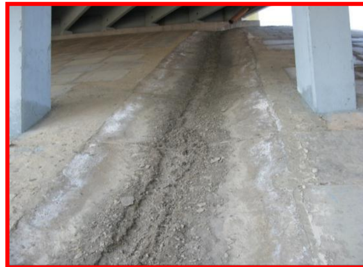
Не очищенная от мусора система водоотвода (водоотводные лотки, гасители и т.д.)
